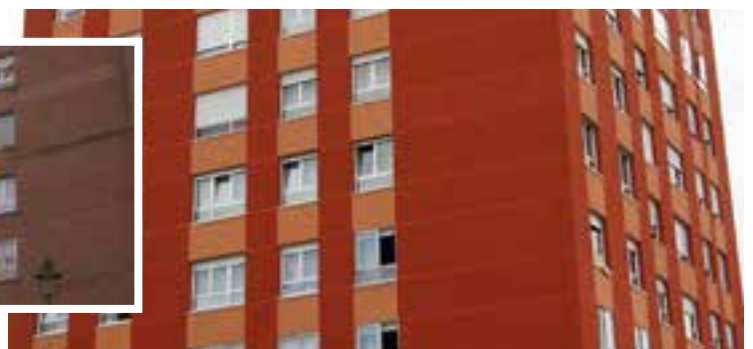
Rehabilitado con sistema Granocryl
